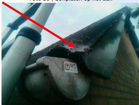
Foto 25 | Golfplaten op het dak
