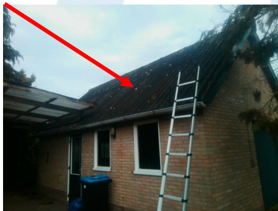
Foto 23 | Golfplaten op het dak
