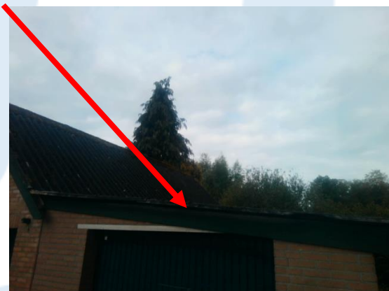
Foto 24 | Golfplaten op het dak
